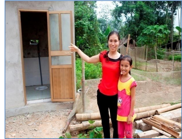
Nhà tiêu HVS mới được xây dựng từ dự án WASHOBA tại Thái Nguyên
